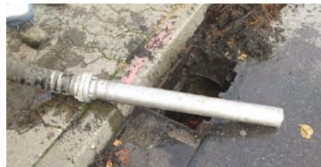
Bild: Reinigung eines nassen Sinkkastens
