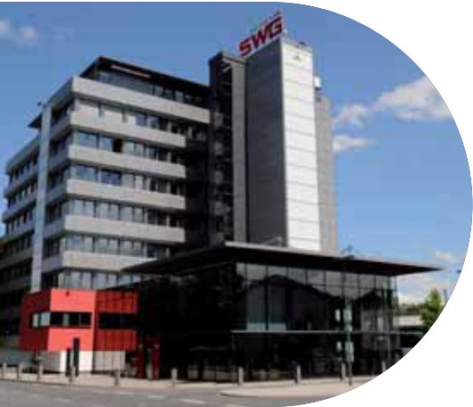
Bild: Hauptgebäude der Stadtwerke Gießen AG
